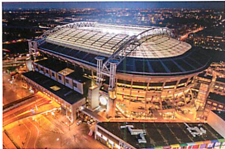
(1) アムステルダム・アリーナの外観
